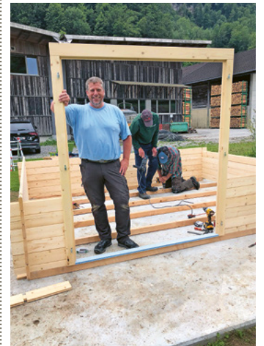
Bau der neuen Materialhütte beim Biathlonstand
